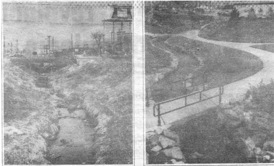
El caso de esta acequia de Colorado, demuestra lo que se puede hacer con un cauce urbano. Izquierda: en 1981, la acequia era un lugar sucio, desagradable e inútil. Derecha: en 1989, luego de un programa de mejoras que no aceptó la "solución" del entubamiento, se ha convertido en lugar de esparcimiento para la comunidad.
